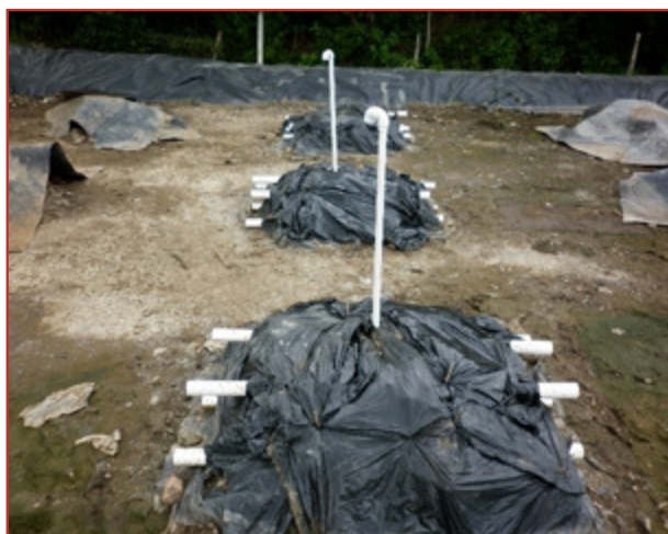
Imagen 4. Biopila de composteo para tratar suelos contaminados con hidrocarburos.
