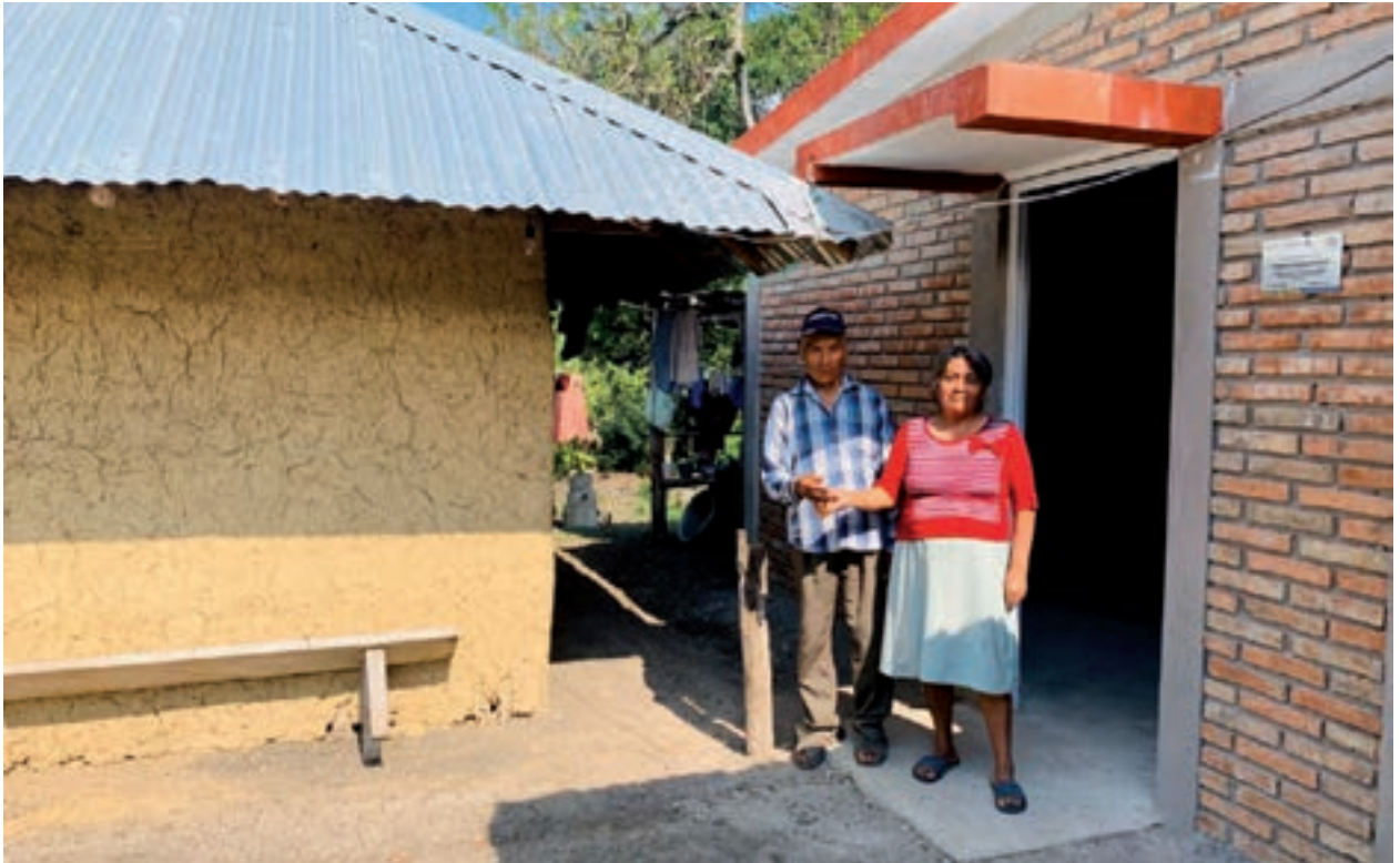
Construcción de cuartos dormitorios, varios municipios.
