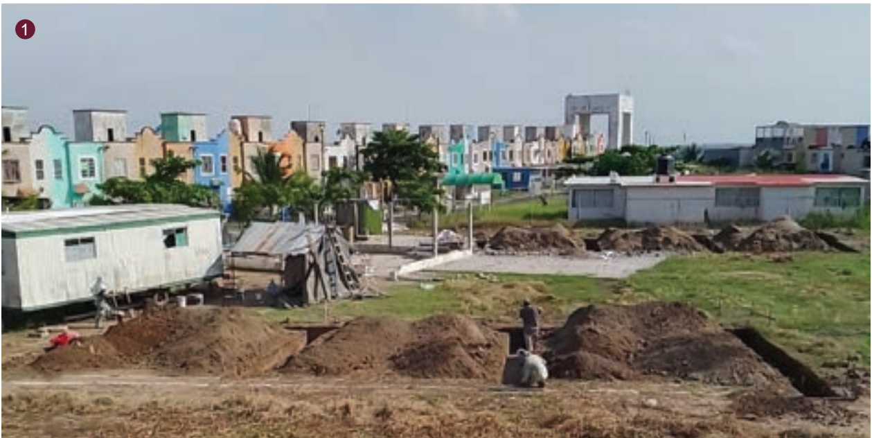
Primaria Juan Nicolás Callejas Arroyo. Construcción de 6 aulas didácticas, dirección, servicios sanitarios.
