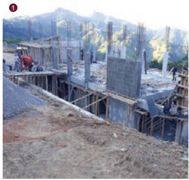
CECYTEV No. 12, Filomeno Mata. Construcción de dos edificios.
