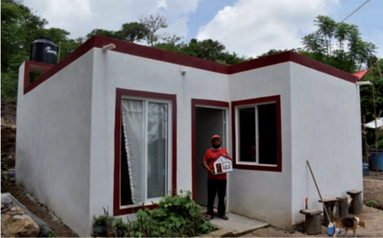
Construcción de cuartos dormitorios, varios municipios.
