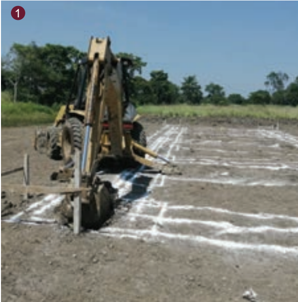
CECYTEV, Plantel Yanga. Construcción de dos edificios tipo U1C de 8 entre ejes y obra exterior.
