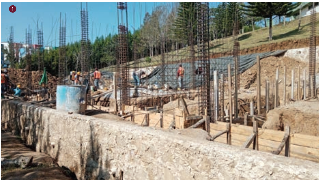
Instituto Tecnológico de Xalapa. Construcción de dos edificios y del Centro de Autoacceso de Idiomas.
