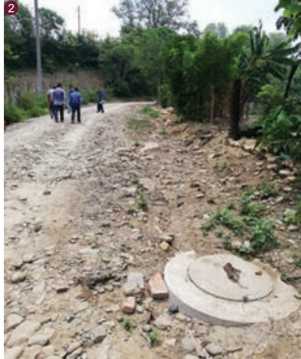
Construcción de drenaje sanitario Ahuica, Chicontepec
