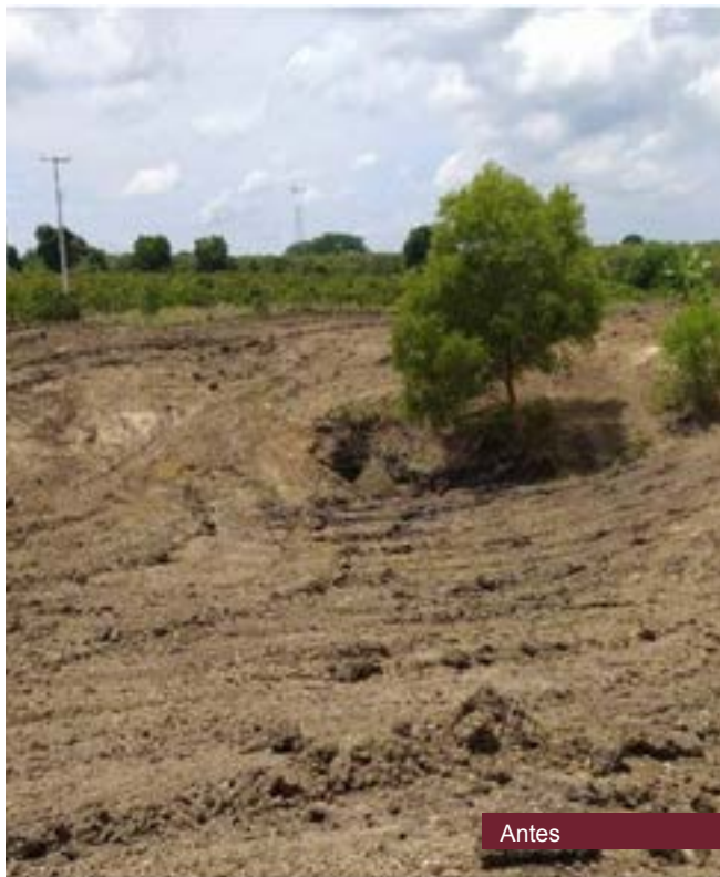
Construcción de bordes de tierra compactada para la captación de agua de escurrimiento pluvial Municipio de Álamo Temapache
