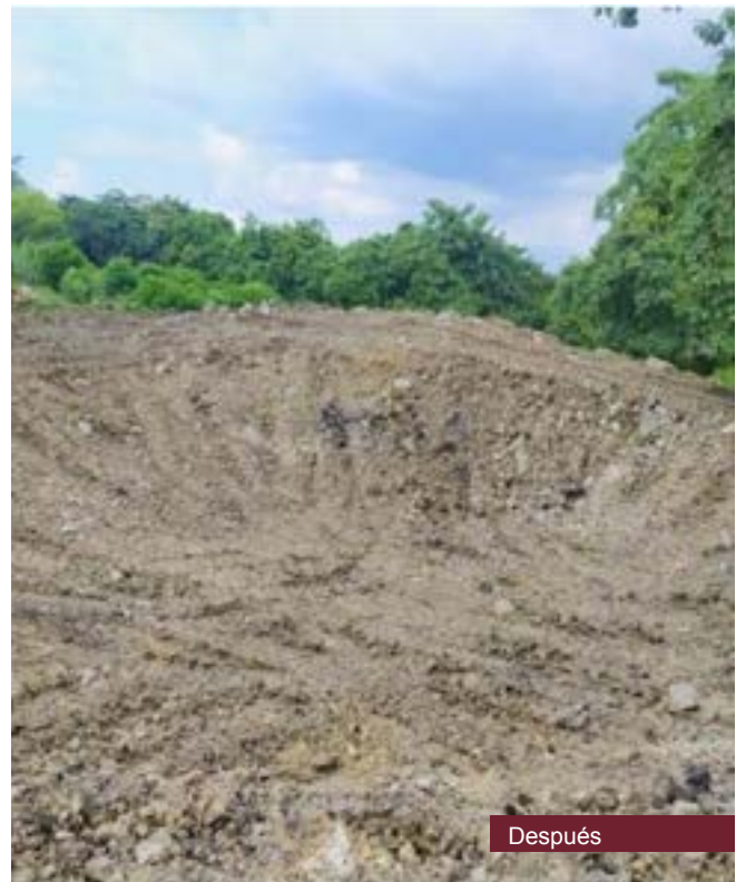
Construcción de bordes de tierra compactada para la captación de agua de escurrimiento pluvial Municipio de Álamo Temapache
