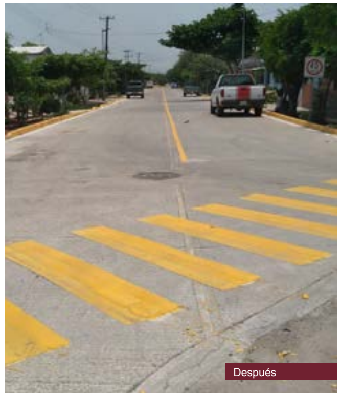
Construcción de pavimento hidráulico en av. Manuel Ávila Camacho, del km 0+000 al km 0+181 Localidad de Pompeya, municipio de Atzalan
