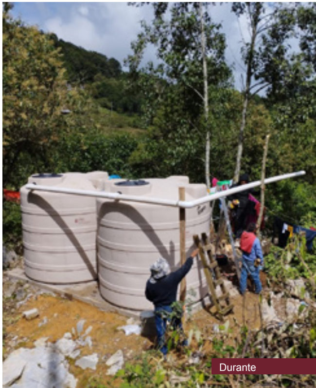
Construcción del sistema de captación de agua de lluvia (primera etapa) Localidad de Tepetlampa, municipio de Tehuipango
