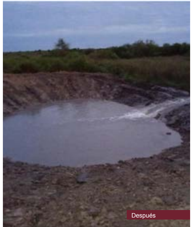
Construcción de bordes de tierra compactada para la captación de agua de escurrimiento pluvial Municipio de Pánuco
