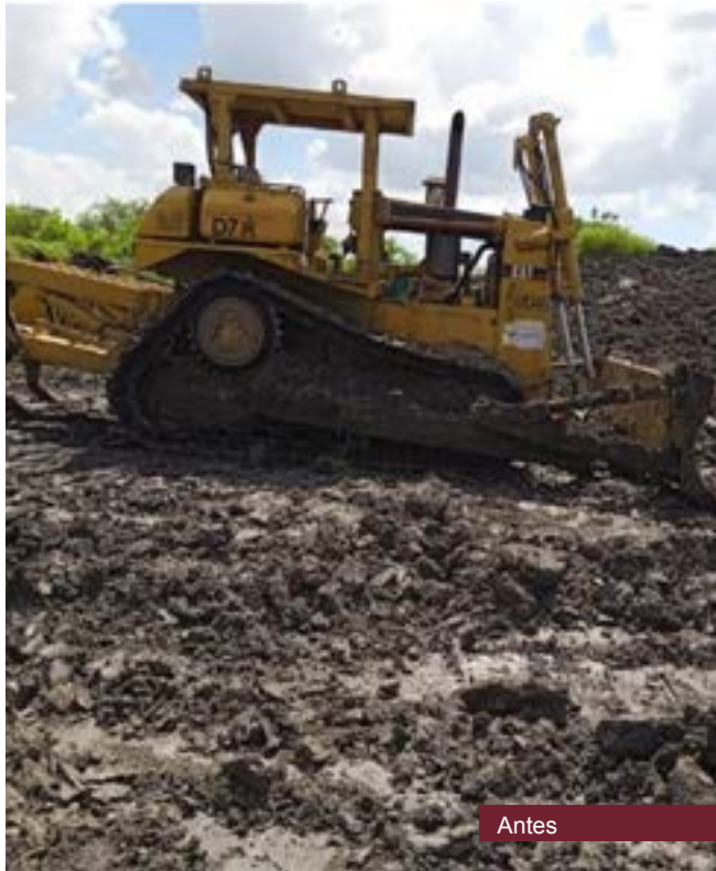
Construcción de bordes de tierra compactada para la captación de agua de escurrimiento pluvial Municipio de Pánuco
