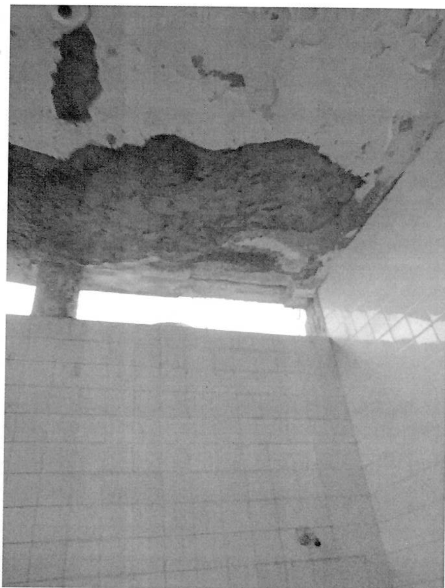
REPARACIÓN DEL TECHO DEL BAÑO
